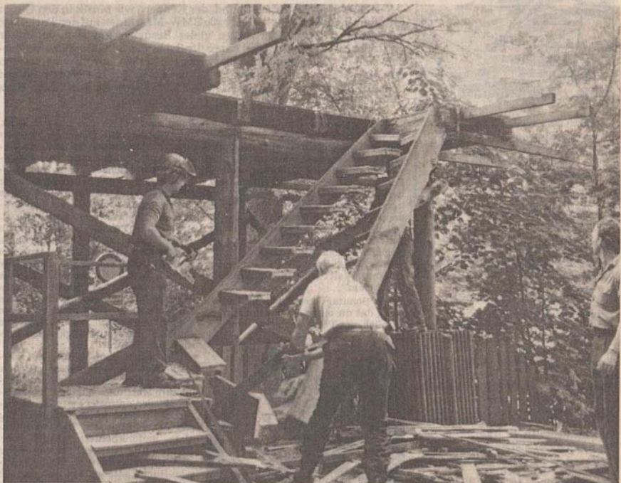
Mitarbeiter des Technischen Zuges des Bundesgrenzschutzes bauten gestern erste Teile der Aussichtsplattform in Eckertal ab. Heute soll das Holzgerüst endgültig verschwinden, das seit den sechziger Jahren Ausblick in die DDR gewährte. Foto: Seilmann
