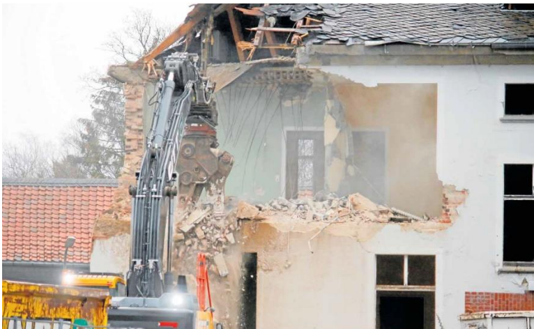
Freier Blick hinein ins Obergeschoss: Der Bagger nimmt sich das Dach und die Hausecke des früheren Stabsgebäudes vor, das aus den 1930er Jahren stammt. Fotos: Epping
